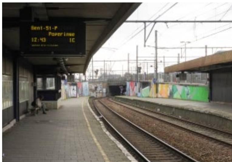
Bestaande dive-under richting Gent
