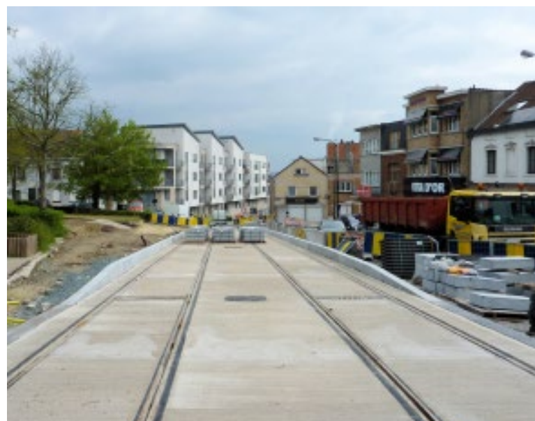
Aanleg tram 10 in Neder-over-Heembeek, halte Zavelput Foto Stefan Stynen
