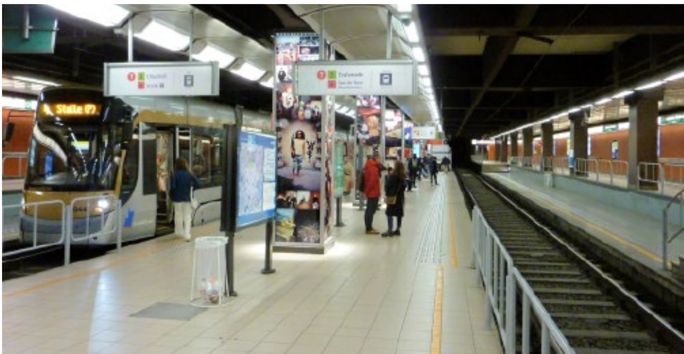
Tram 4 in Annessens, waarbij zichtbaar is dat de perrons deels verlaagd werden voor de trams, maar op metrohoogte werden gebouwd.
