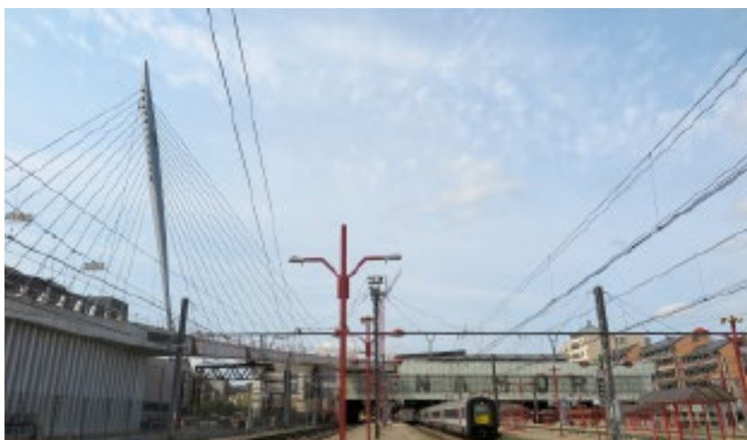
Op het dak van station Namen ontstaat een nieuw busstation. De brug ernaartoe is alvast gedurd te noemen. Foto Jacques Peeters
