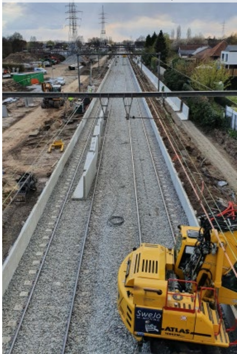
Werzaamheden aan het perron in Kiewit en aan beide sporen tegelijk Foto Willy Smeulders
